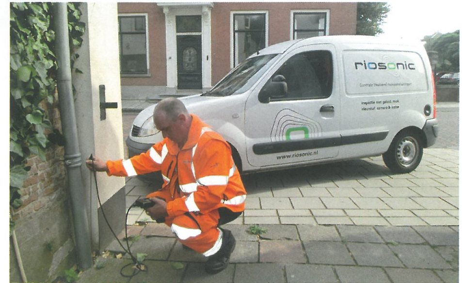
Met de Riosonic wordt de regenpijp gecontroleerd.
